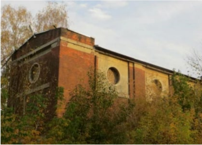
3. В годы войны стратегический объект. Электрическая подстанция
